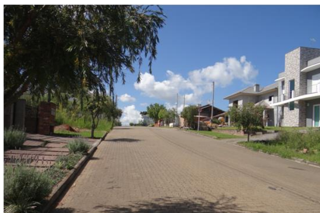
BLOCO DE CONCRETO
